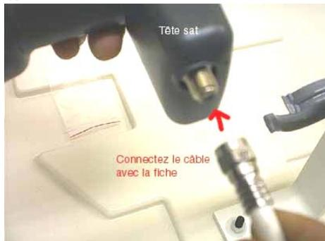
Connectez le câble de 50cm entre l'embout que vous avez fixé sur la paroi et la tête universelle ou entre le commutateur Disecq et l'embout dans le cas où votre Cusat est équipé de plusieurs têtes
